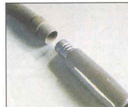
Простой, но достаточно надежный способ удержания шланга на краю ванны — закрепить отрезок трубы на конце сливного шланга.
