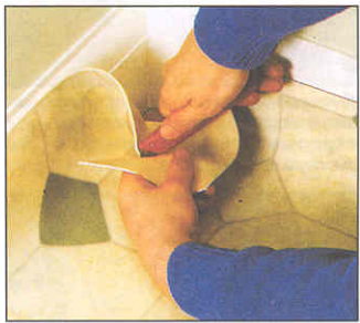
При укладке линолеума у внешнего угла делают разрез по диагонали (сверху), а у внутреннего угла (снизу) линолеум вырезают так, чтобы он лег без пузырей.
